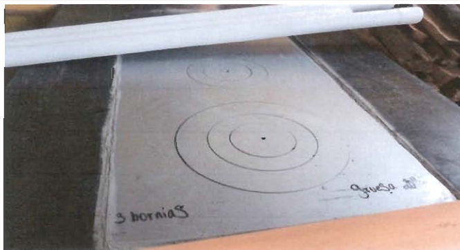
Foto 3: planchas colocadas en la cocina del establecimiento
