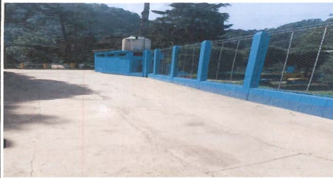
Foto 1: evidencia de la finalización del pintado del muro o circunvalación
