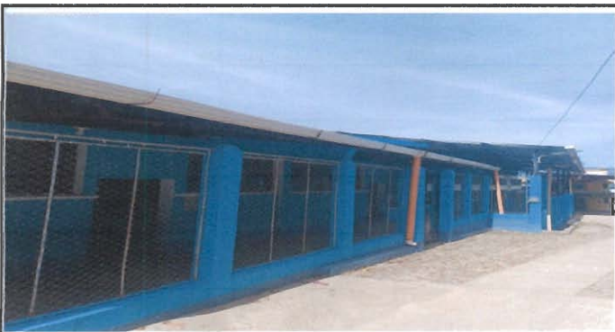
Foto 5: fotografía indicando la conclusión del pintado de la parte de enfrente
